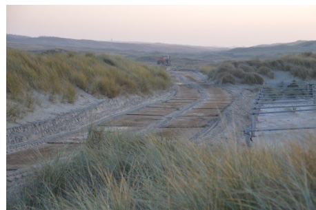
Rijplaten als tijdelijke route tussen Schoorl aan Zee en de Mariaweg
