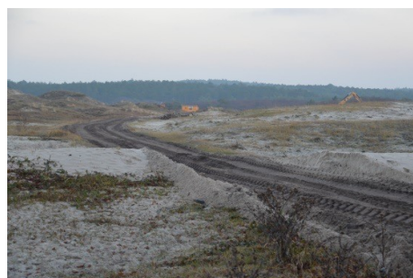
Afgraven ten zuiden van de Mariaweg
